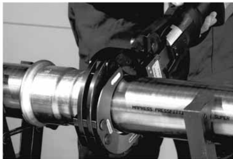
Slika 40: Postupak stiskanja s obujmicom za stiskanje ø 42 - 108 mm
