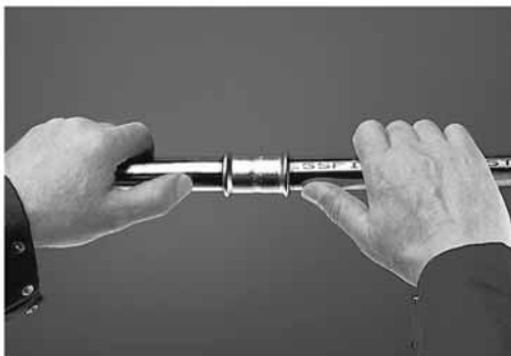
Slika 25: Umetanje sistemske cijevi u spojni element za stiskanje
