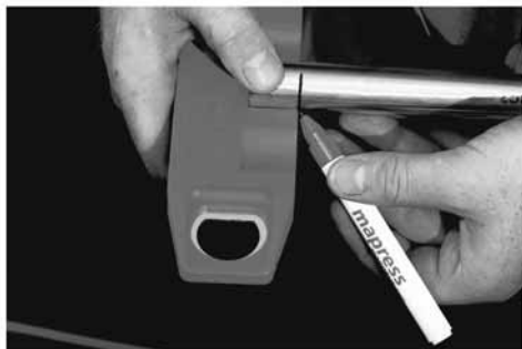
Slika 20: Označavanje dubine umetanja sa šablonom za dubinu umetanja
