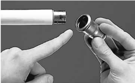
Slika 36: Provjeravanje brtvenog prstena
