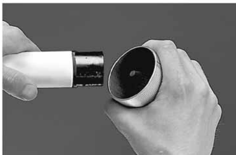
Slika 34: Vanjsko i unutarnje skidanje rubova bakrene cijevi s ručnim skidačem rubova
