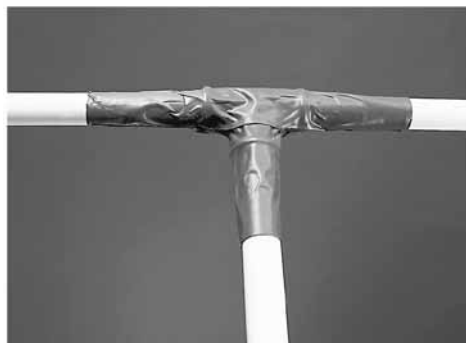
Slika 70: Konačno namještena traka za zaštitu od korozije
